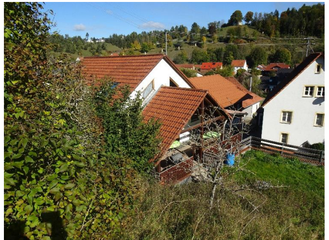
Foto 10: 6 – Blick von Südwesten auf das nördlich angrenzende Wohnhaus
