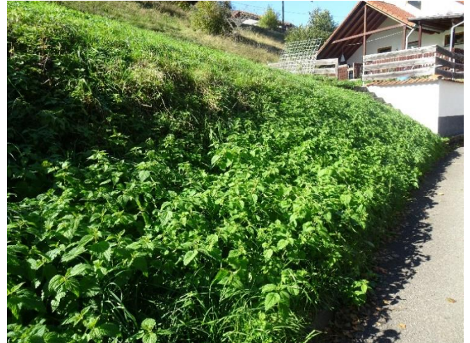
Foto 2: 1 - Straßenböschung bestehend aus dichtem Brennnesselbewuchs
